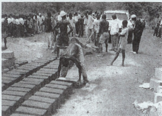
De bouw van de school in Dia is inmiddels gestart.
